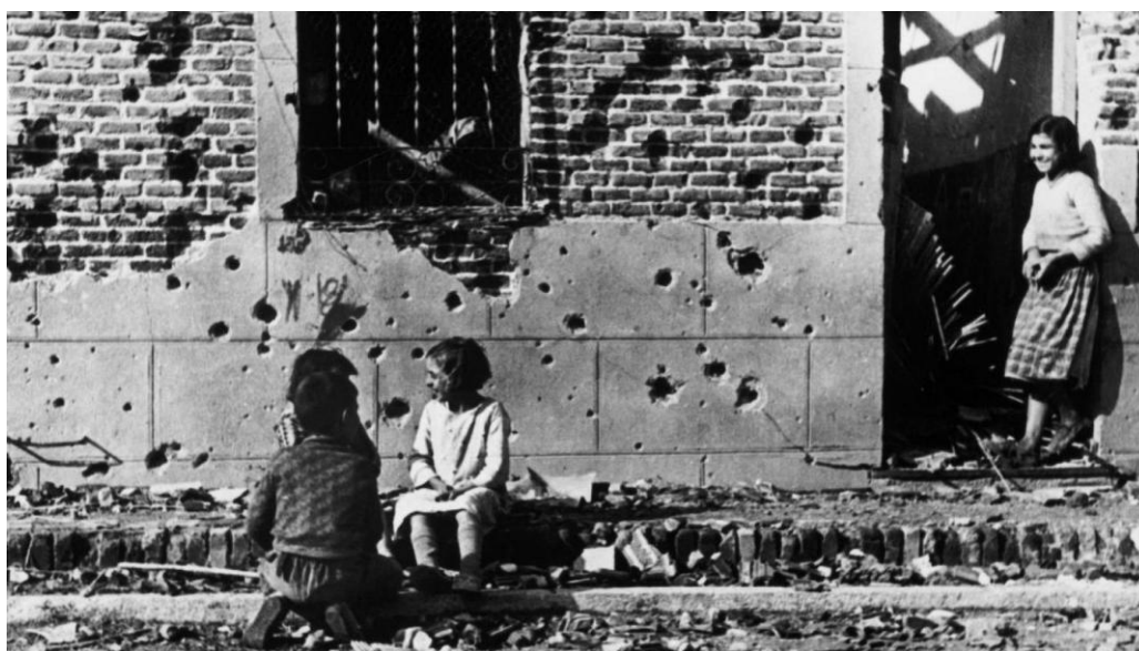
Figura 4. Niños jugando frente a una fachada completamente destruida por la metralla. Noviembre de 1936. Vallecas, Madrid. Autor: Robert Capa.
